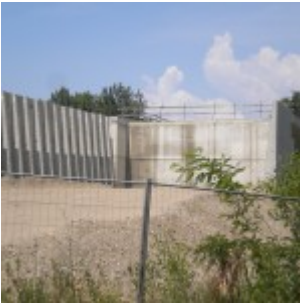
Viadotto mai finito nei pressi di Gassano
