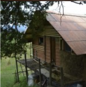
Gli strati della costruzione sono ben visibili. Tra fango, paglia e listelli di legno la tenuta e la stabilità appaiono sorprendenti.
