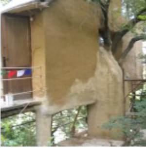
Il tronco fa da pilastro della casa sull'albero
