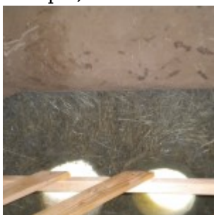
Intercapedine di un muro composta di paglia e fango
